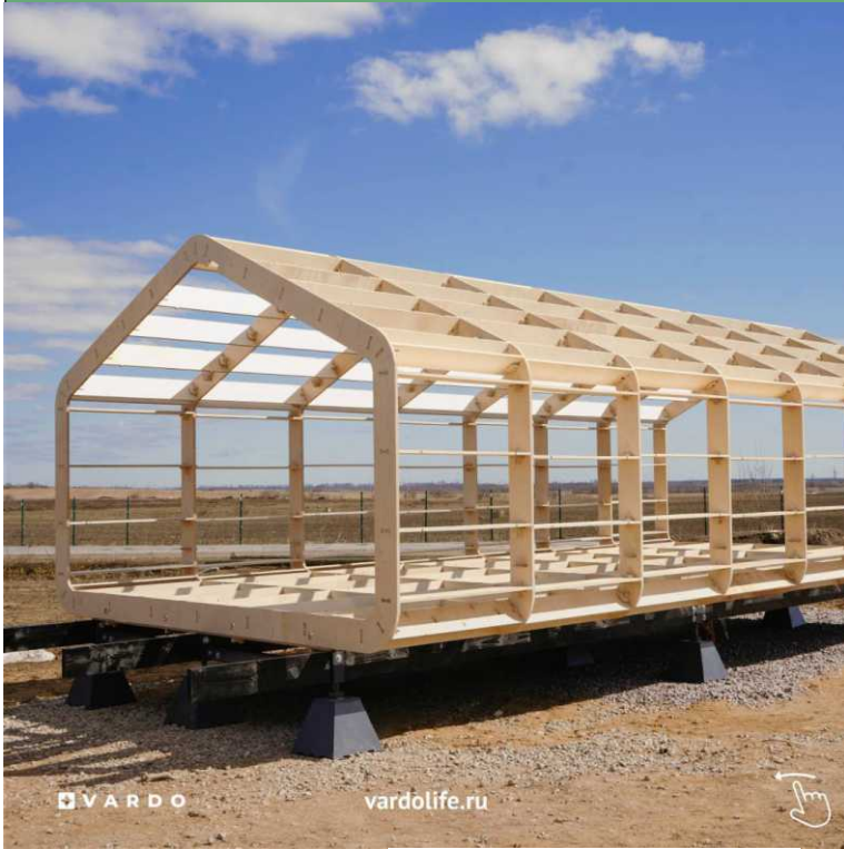
Шаг 1. Подготовить фундамент и собрать деревянный каркас основания.
